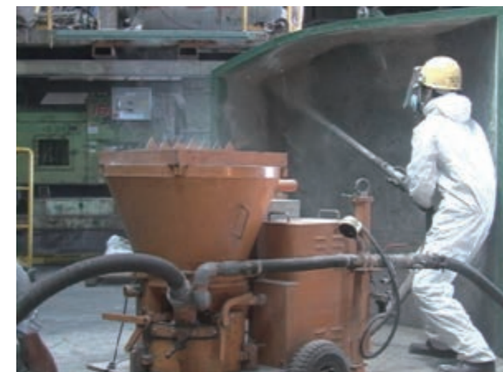
発塵抑制型乾式吹付装置SRGでの吹付施工
