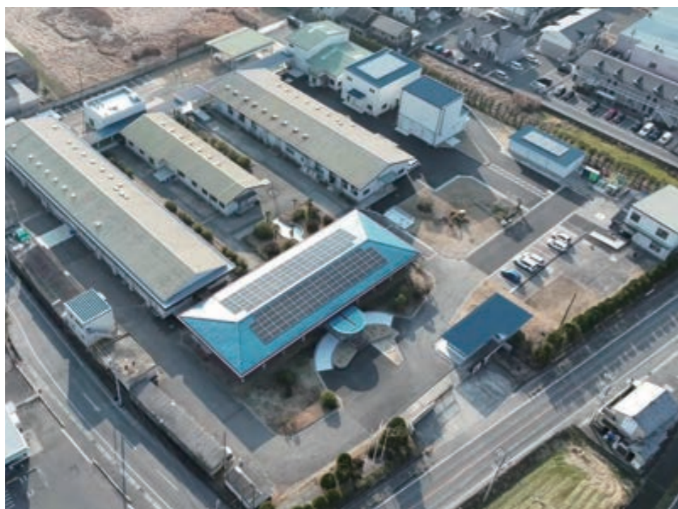
瀬戸内工場(2026年2月竣工)
