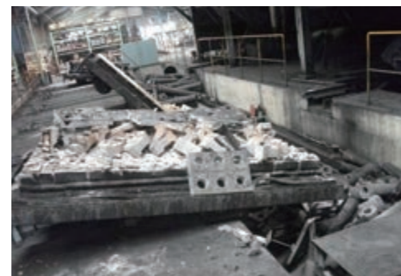
焼成台車：地震による転倒で製品が破損
