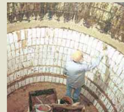
築炉技能士による施工
