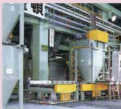
原料受入れヤード
