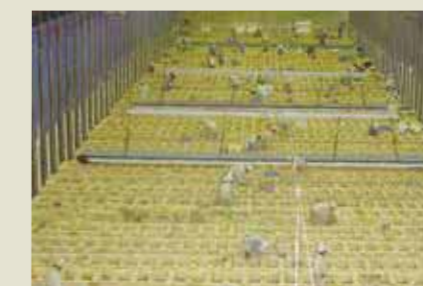
築炉中のコークス炉
