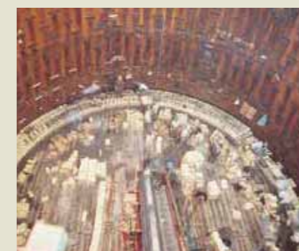
高炉施工工事
